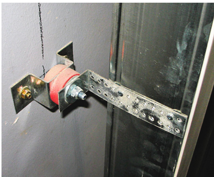
Каркас звукоизоляционной облицовки KNAUF W626, смонтированный с помощью эластичных креплений Vibrofix Uni L
